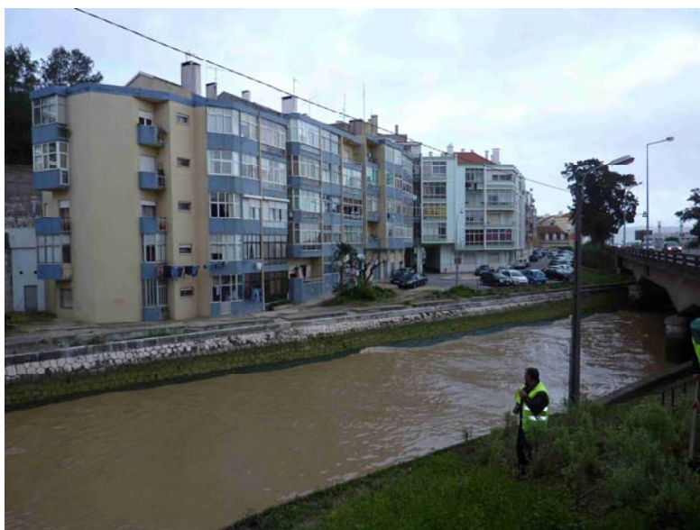
Fotografia 9 – Leito de cheias na margem esquerda do rio Jamor a montante da ponte da Av. Marginal (vista para montante).
