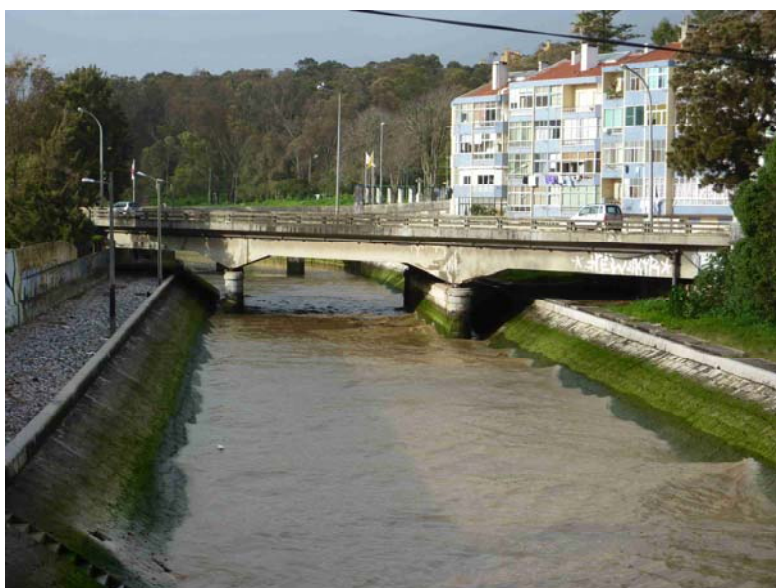
Fotografia 2 – Ponte da Av. Marginal (vista para montante).
