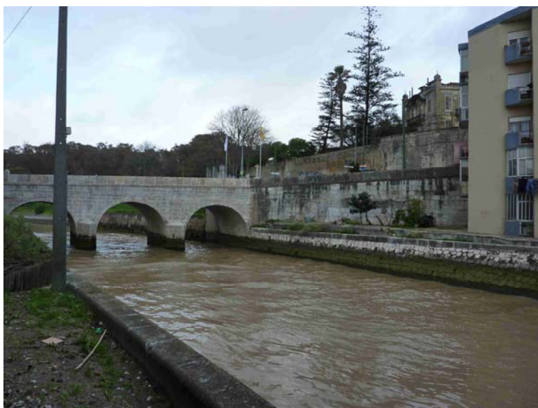
Fotografia 3 – Ponte da Av. Pierre de Coubertin (vista para montante).
