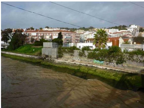
Fotografia 6 – Leito de cheias na margem esquerda do rio Jamor e secção regularizada do rio Jamor entre a ponte da Av. Pierre de Coubertin e a ponte da REFER (vista para montante).
