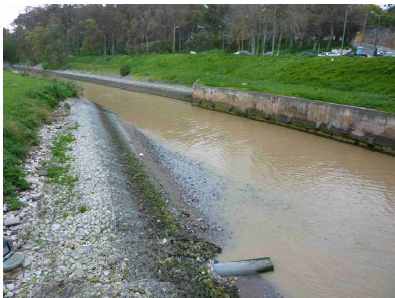
Fotografia 4 – Secção regularizada do rio Jamor a montante da ponte da Av. Pierre de Coubertin (vista para montante).
